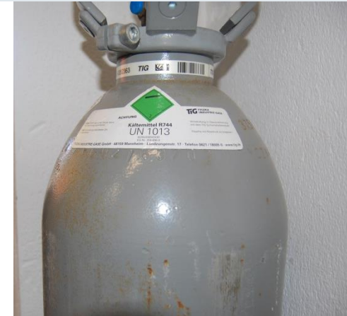
Bild Links: Eine Kälteanlage in einem Technikraum von einem Supermarkt; Bild Mitte: Kompressoren einer Kälteanlage mit Ammoniak, Bild Rechts: Eine Flasche mit dem Kältemittel Kohlendioxid
